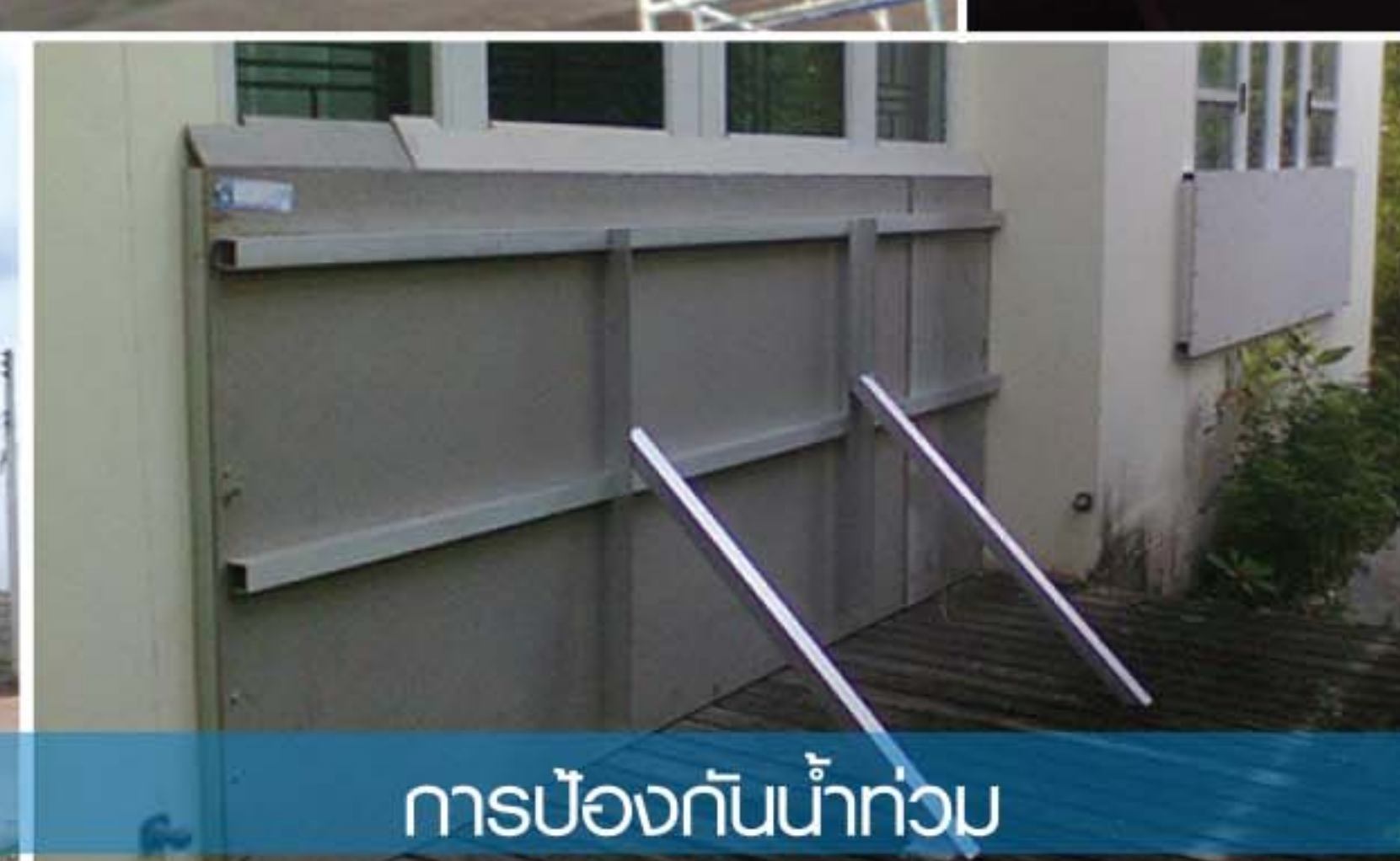
แบบหล่อถาวร (Permanent Formwork)
